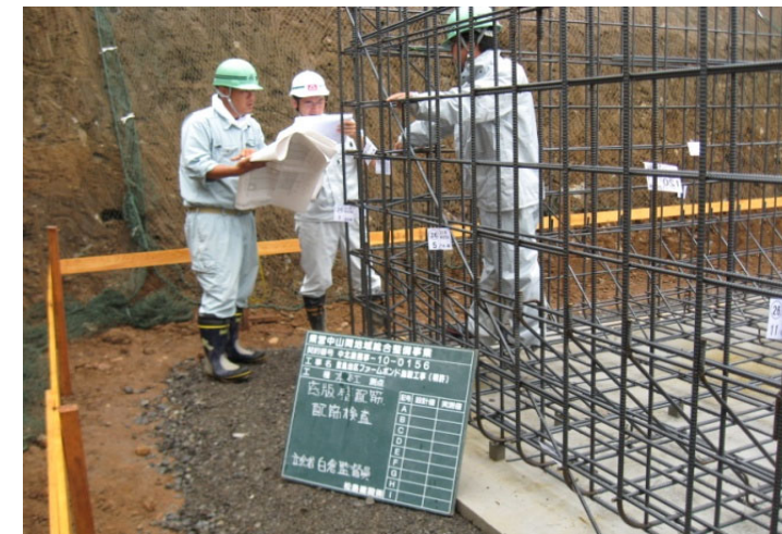
ファームポンド配筋検査
