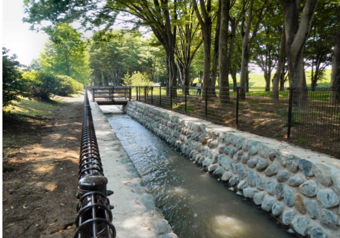
用・排水路整備
